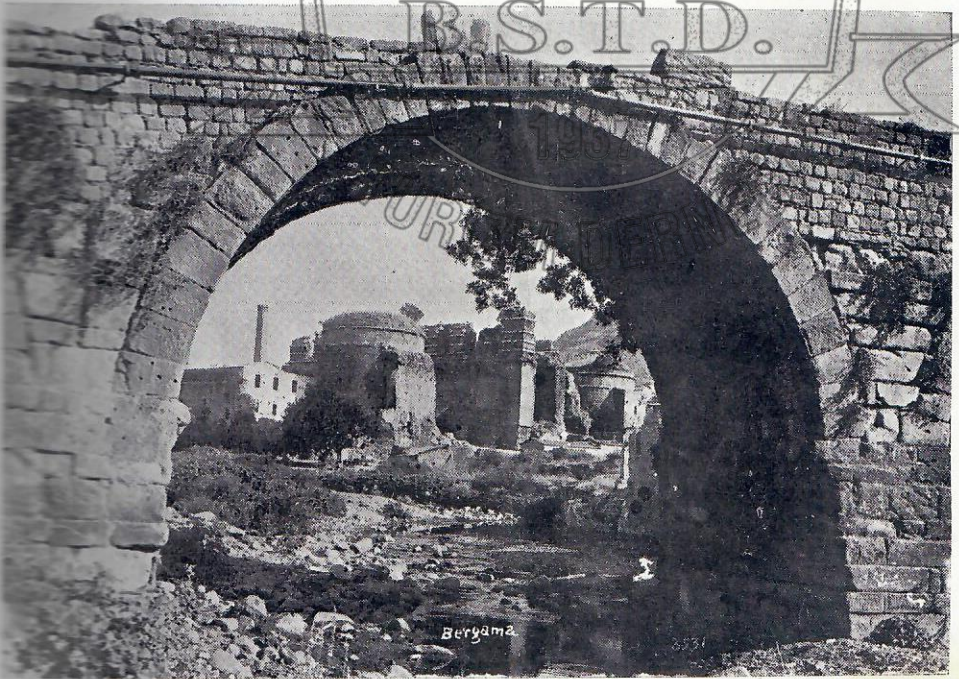
Bergama Deresi üzerinde üç Kemer Köprüsü
